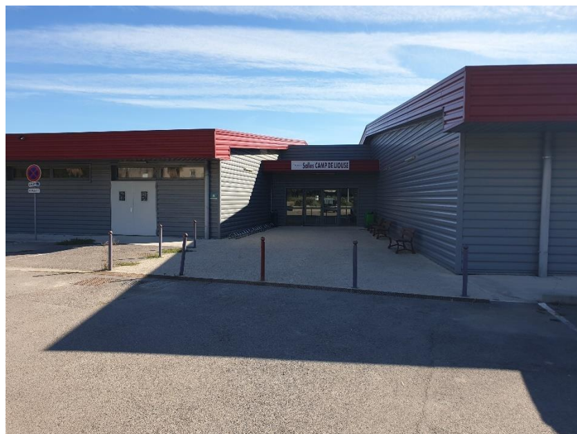
Vue de devant des locaux de la MJC
